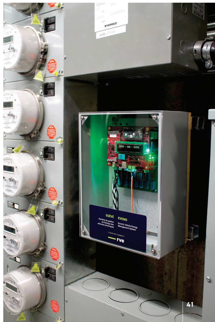
Figure 3 : Le SGÉVÉ multiniveaux (un modèle de démonstration du HUB de RVE) installé dans le cadre d'un projet pilote dans un immeuble multilogement de Laval.
