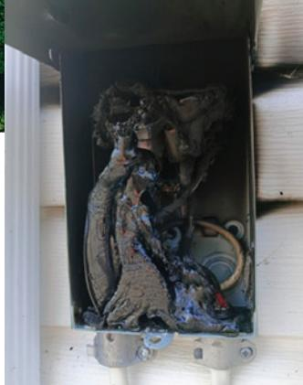
Sectionneur de thermopompe utilisé pour une borne de recharge.
