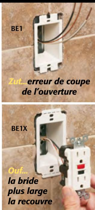
Nos rallonges de boîtier homologuées UL/CSA permettent de prolonger les boîtiers électriques métalliques ou non métalliques encastrés d'au plus 3,81 cm (1 ½ po).
