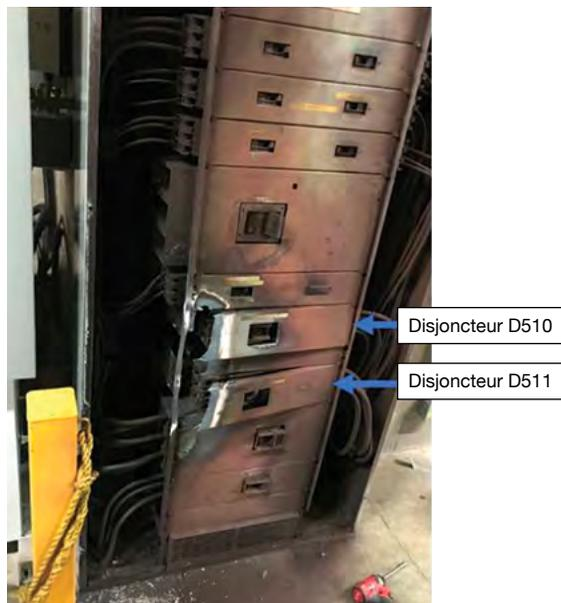
**Figure 18 : Effet des éclats d'arcs sur le panneau S (projecteurs latéraux retirés) (source : CNESST)**
