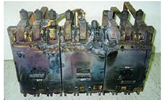
Figure 1 - Défaillance du disjoncteur causée par une surtension majeure
