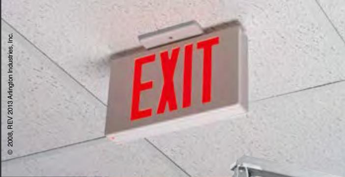
La boîte pour luminaire monobloc entièrement en métal d'Arlington est livrée prête à installer sur une ossature de faux-plafond de 60,9 cm (24 po) – aucun assemblage requis!
