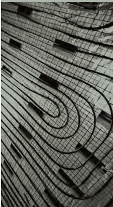
Les câbles et trames de type « enfouissement » conviennent idéalement aux projets de nouvelles constructions puisqu'ils sont installés avant que la dalle de béton ne soit coulée.
