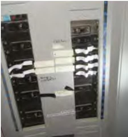
Moyen douteux pour contrôler l'énergie sur un panneau de distribution : avec du ruban isolant (Source : CNESTT)
