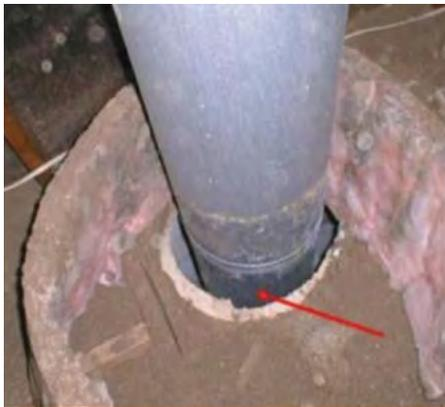
Photo 1 Conduit pénétrant dans un ensemble résistant au feu
