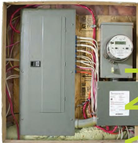
**Image 3 :** Exemple d'installation d'un contrôleur de charge pour véhicules électriques DCC-10 en maison
