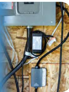
**2** Un contrôleur de charge électrique additionnel pour contrôler la pompe de la piscine est installé à côté du premier par souci pratique.
