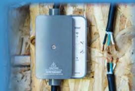
**3** Le contrôleur de charge est fixé au mur, prêt à recevoir les fils coupés et dégainés.
