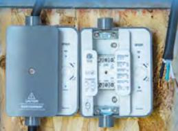
**4** Chaque fil est placé dans le terminal approprié, puis les borniers de connexion sont vissés fermement.
