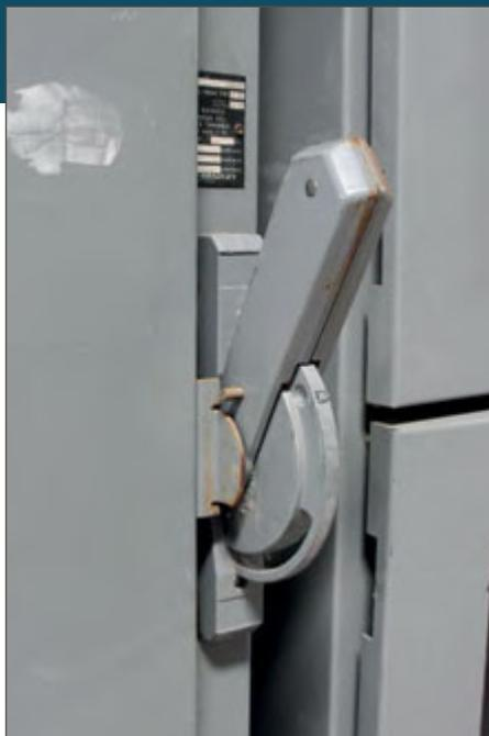
Sectionneur de type CCM Allen-Bradley Centerline 5 KV
