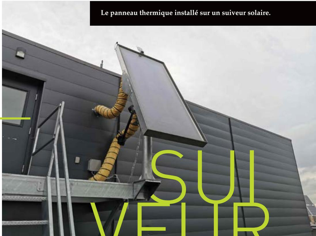
Le panneau thermique installé sur un suiveur solaire.
