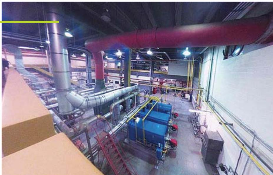
Les nouvelles chaudières à haute efficacité installées dans la centrale thermique de l'UQTR ont été dimensionnées pour répondre à la nouvelle demande.
